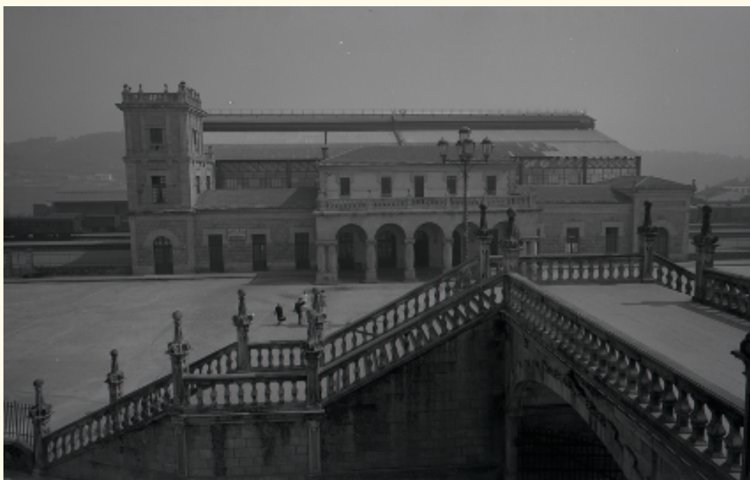
Estación de Ferrocarril de Santiago de Compostela, proxecto do ano 1932, inaugurada no 1943 (Archivo Histórico Ferroviario)
